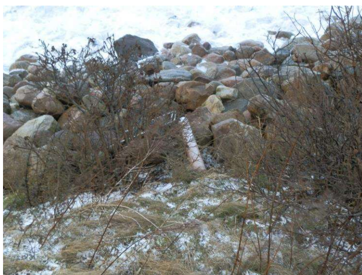
Figur 15 Billede af eksisterende udløb, fra Helsingør Kommunes registrering.
