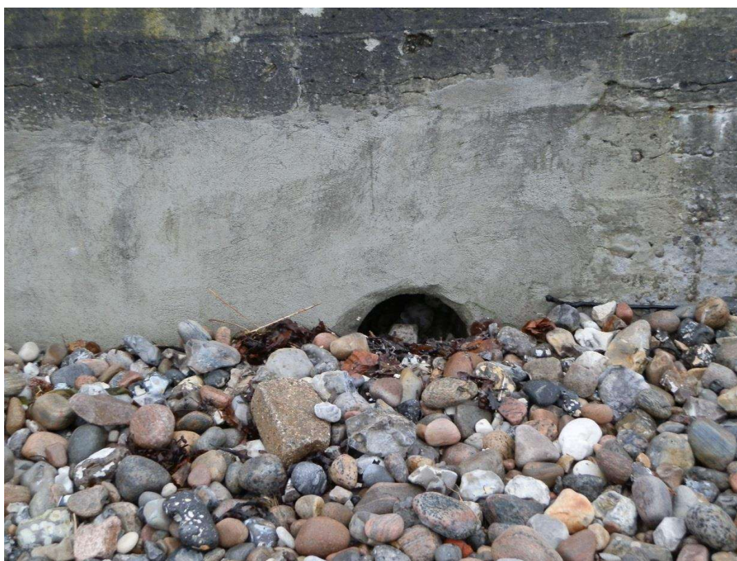
Figur 9 Billede af eksisterende udløb, fra Helsingør Kommunes registrering
