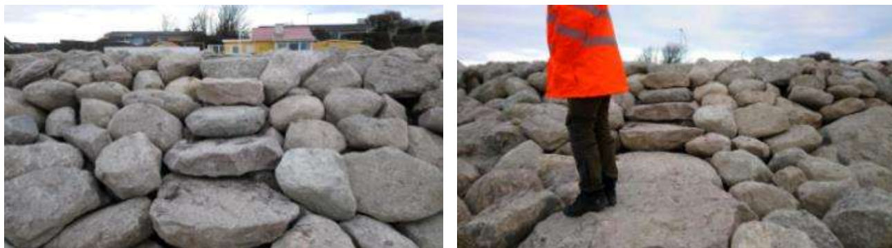
Figur 4 Billede af eksempel på stentrappe over høfde.
