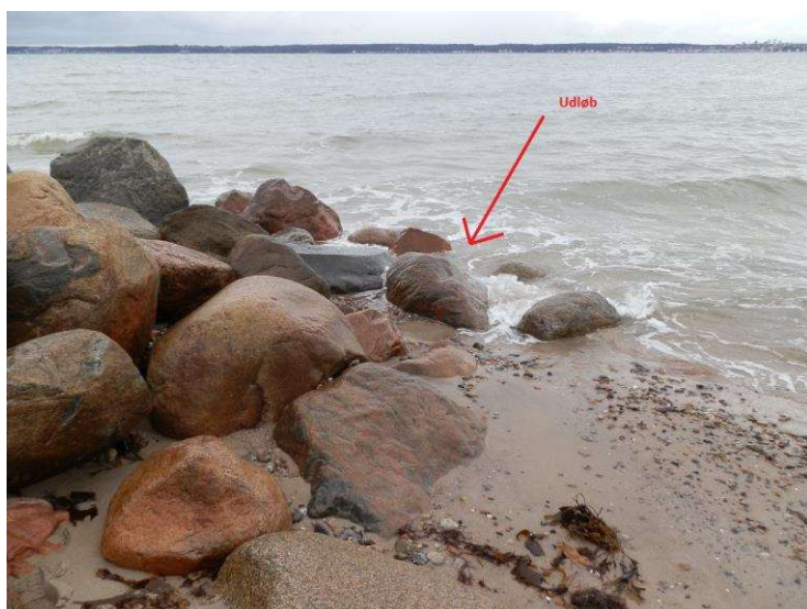
Figur 5 Billede af eksisterende udløb, fra Helsingør Kommunes registrering
