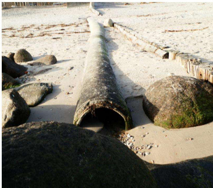
Figur 6 Billede af eksisterende udløb, fra Helsingør kommunes registrering.
