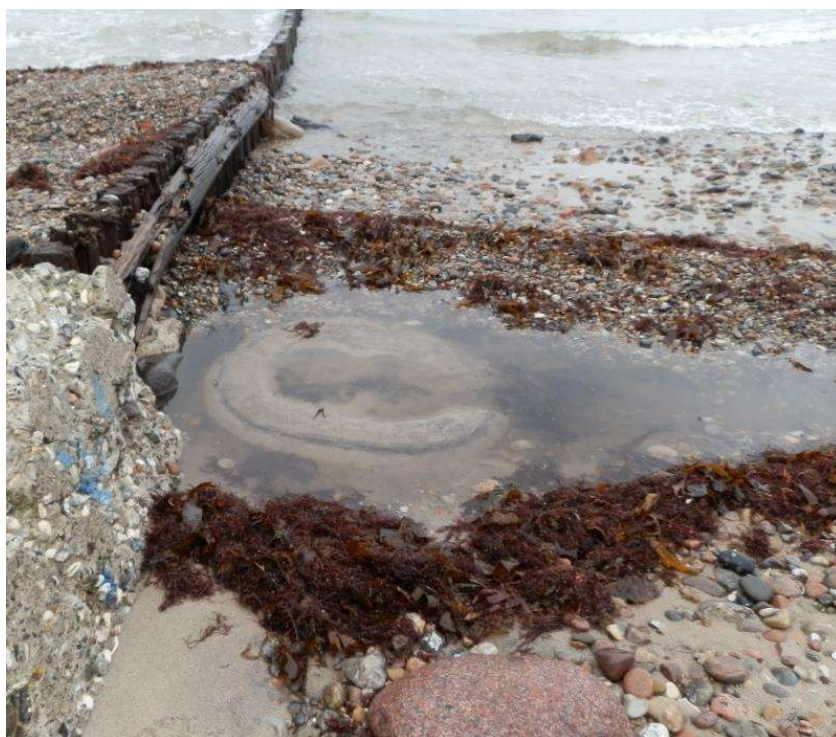
Figur 7 Billedet af nærmeste brønd ud for eksisterende udløb, fra Helsingør Kommunes registrering
