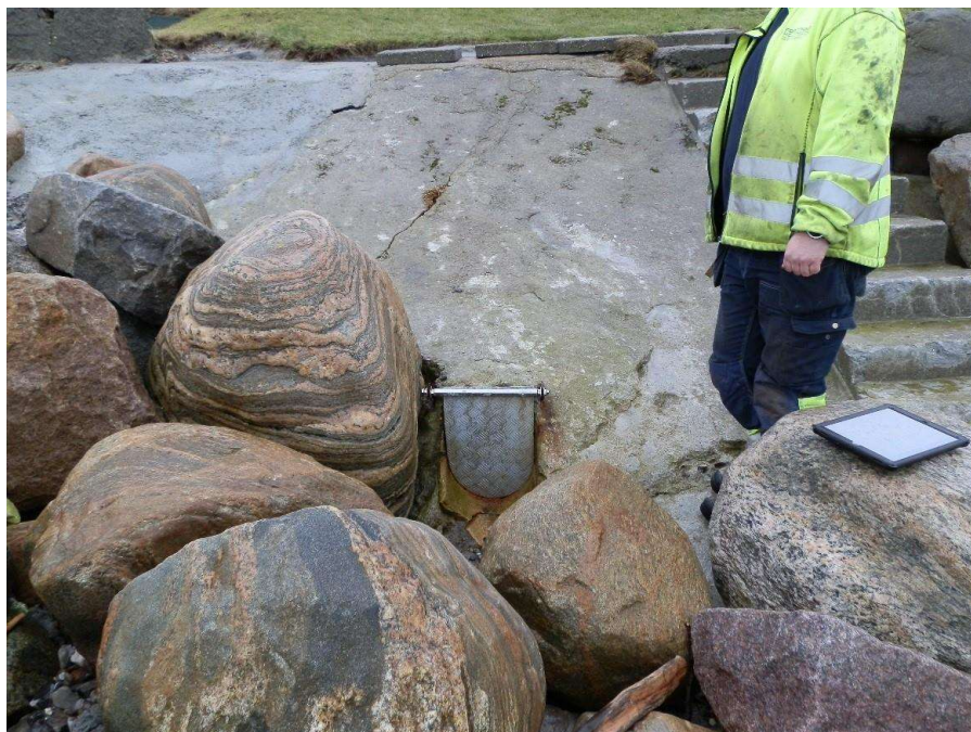
Figur 12 Billede af eksisterende udløb, fra Helsingør Kommunes registrering
